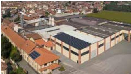
2300 m<sup>2</sup> di pannelli fotovoltaici Vitovolt 300 M-WA da 345 Wp l'uno per una potenza complessiva di 402 kW.
