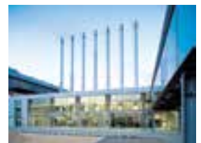
La centrale termica degli stabilimenti Viessmann di Allendorf
