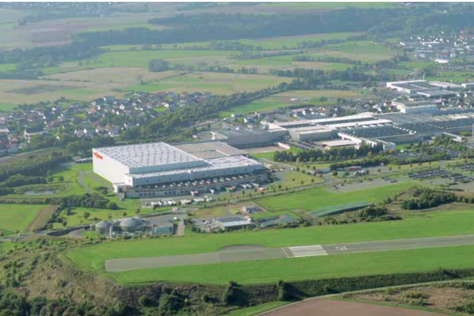
Allendorf (Germania), vista aerea della sede centrale Viessmann
