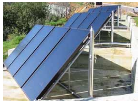
Pannelli solari termici piani Vitosol 200-F
