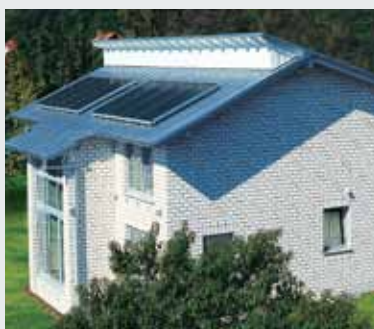
Abitazione monofamiliare a Bad Füssing, Germania
