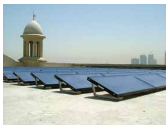
Pannelli solari termici piani Vitosol 200-F
