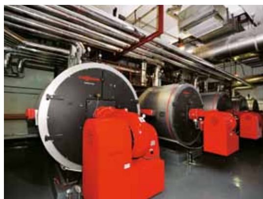
Caldaie per acqua calda Vitomax 200-LW
