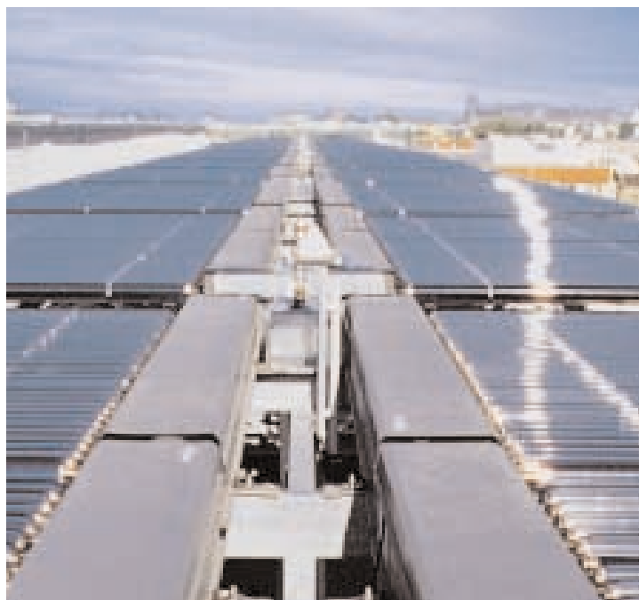
Collettori Vitosol 200 con una superficie di assorbimento complessiva di 240 metri quadrati per la produzione di aria fredda e come supporto per il riscaldamento nell'ufficio stampa del governo federale.
