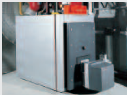
Per la riqualificazione dell'impianto di riscaldamento presso l'Hotel Edelweiss è stata scelta una caldaia Viessmann di media potenzialità Vitoplex 300
