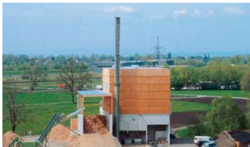
Centrale elettrica a biomassa, Fussach, Austria
