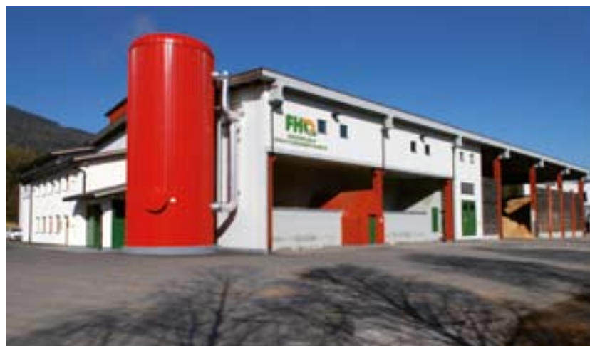
Impianto con due caldaie FU 4000 RA e una caldaia FSR 5600 kW olio diatermico con ORC 650 kW Teleriscaldamento, Valdaora/Olang (BZ)
