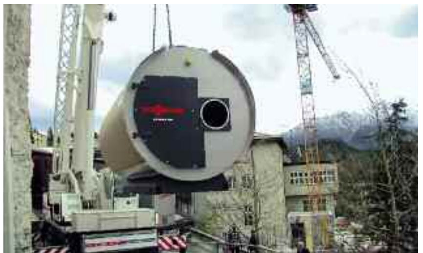
Posizionamento di una caldaia Vitomax
