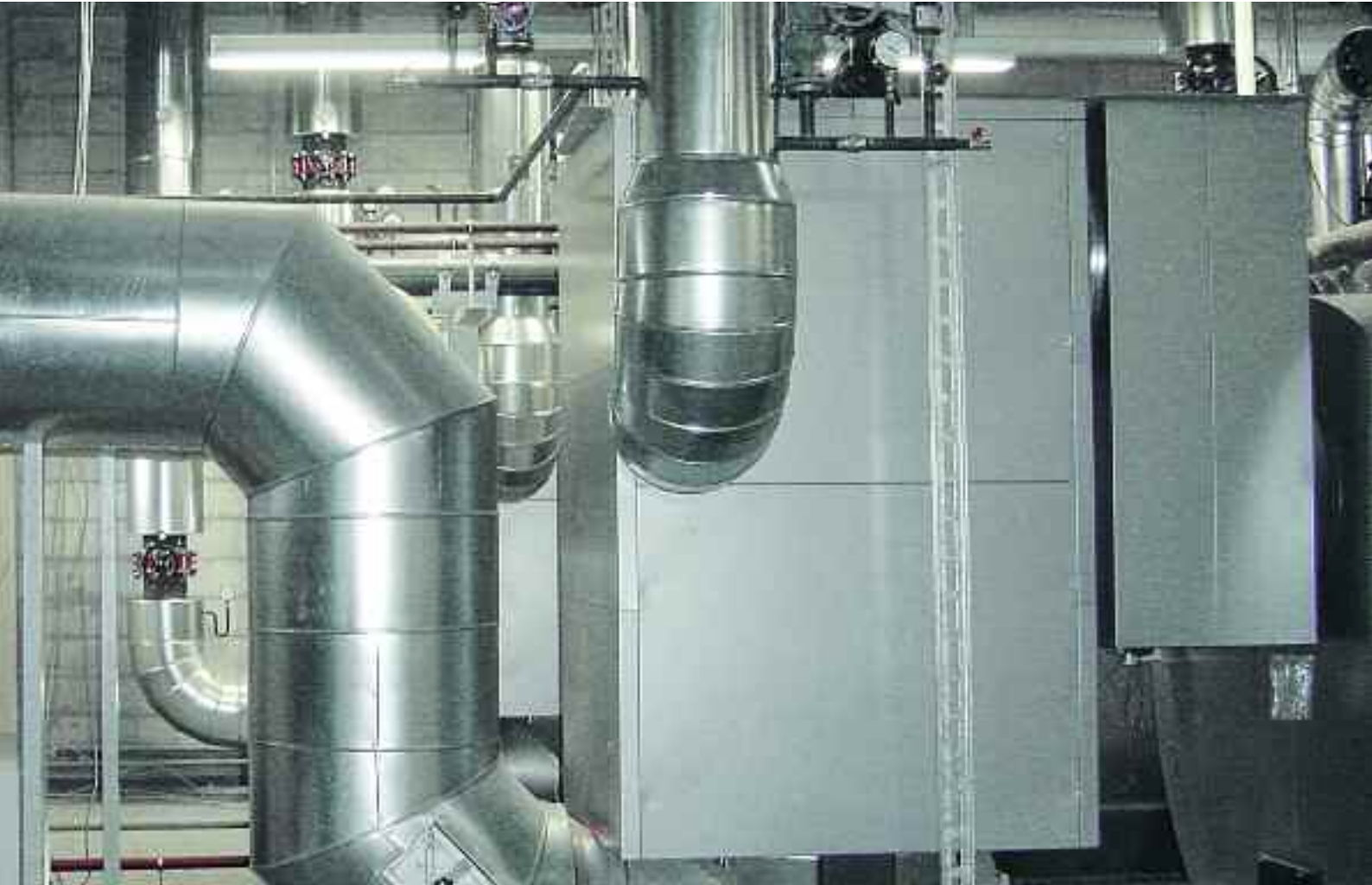
Scambiatore di calore fumi/acqua Vitotrans 300
