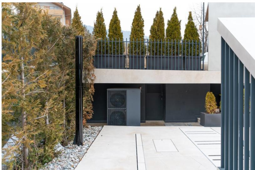
Pompa di calore aria-acqua Vitocal 200-S di Viessmann
