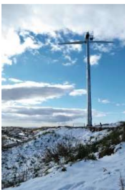
Impianto eolico di Elettro Costruzioni
