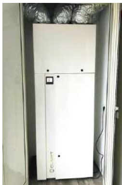
Pompa di calore inverter elettrica ad alta efficienza di tipo splittato a incasso Sphera di Clivet.
