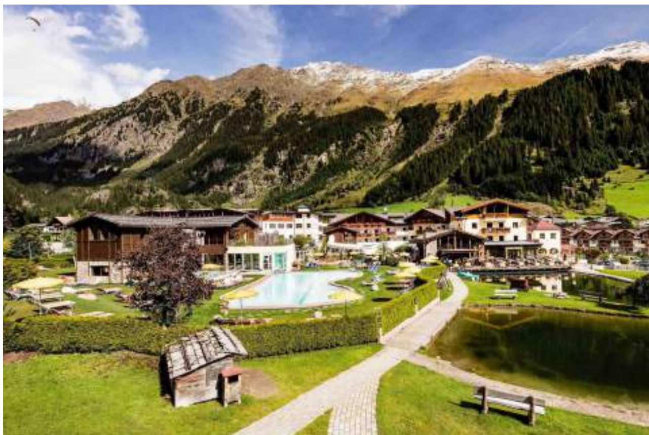
Viessmann | Nuova caldaia a legnao nell'hotel Schneeberg.
