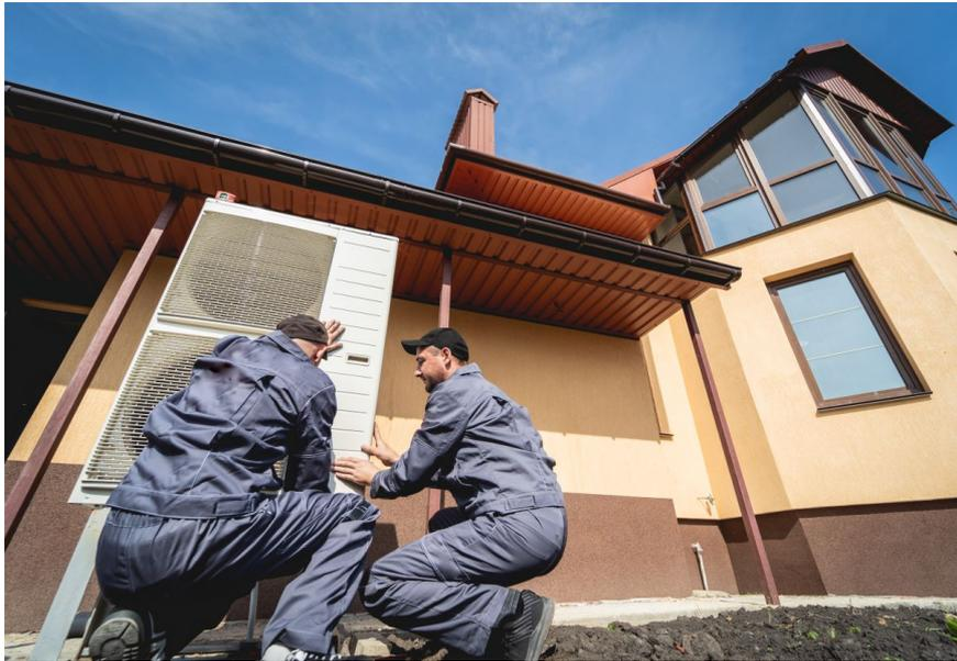
Per il trasporto dell'energia utilizzano un fluido che, una volta venuto a contatto con l'evaporatore, cambia di stato trasformandosi in materia gassosa.
