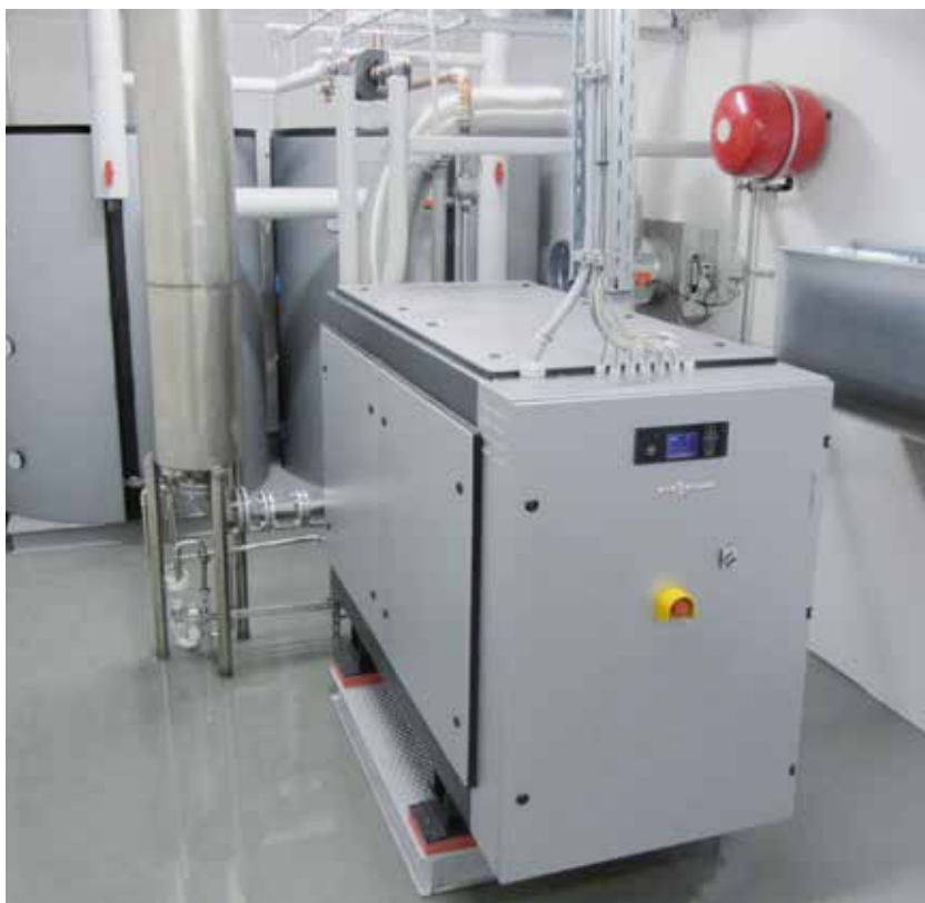
Vitobloc 200 è dotato di generatore sincrono
