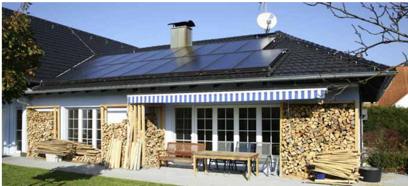
Impianto solare termico con pannelli piani Vitosol 200 -FM
