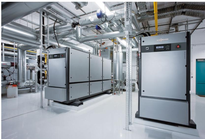
Impianti di cogenerazione per produrre calore ed energia elettrica nella gamma di potenza da 6 a 530 kW
