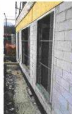
FACCIATA SUD E CONTROTELA MONTATA
