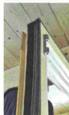
POSA SERRAMENTO CON NASTRO MULTIFUNZIONE
