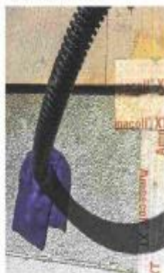
TENUTA ALLA RIVA PASSAGGIO IMPIANTI
