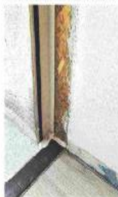
POSA SERRAMENTO CON SCHIUMA DI PVC E MSPOLIMERO
