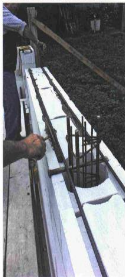
POSA BLOCCO CALCESTRUZZO CELLULARE AUTOCLAVATO
