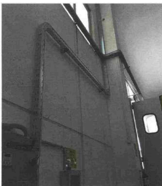
Particolare della condotta di collegamento tra gruppo inverter, posizionato sul tetto, e quadro interfaccia, posizionato all'interno dell'edificio
