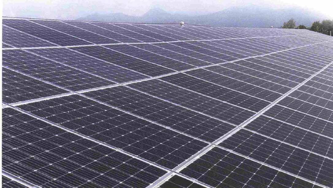
L'impianto fotovoltaico è composto da 3.277 pannelli fotovoltaici Vitovolt 300 di Viessmann, abbinati a 26 inverter Huawei FusionSolar. Vi sono in campo 13 diversi angoli di tilt ed azimut ed una parte viene ombreggiata da strutture di sostegno
