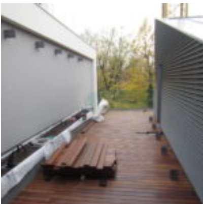
Posa dei pavimenti delle terrazze.
