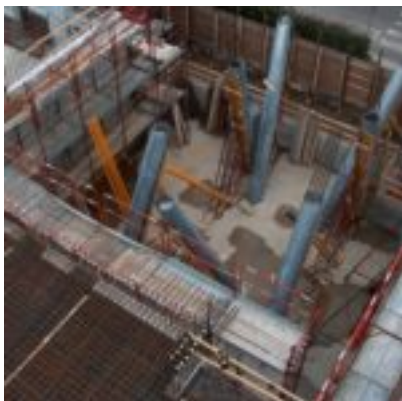
Armatura dei pilastri inclinati.
