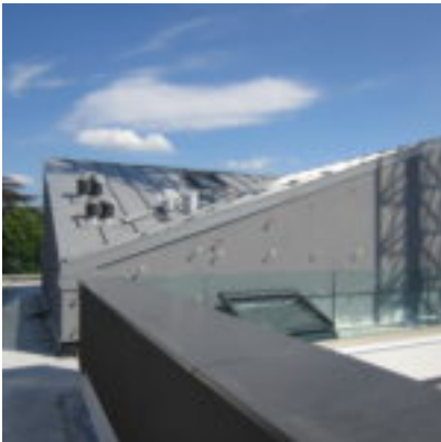
Rivestimento delle torrette.
