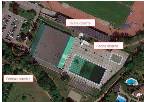
Riqualificazione centrale termica del Centro natatorio di Desenzano del Garda, Brescia
