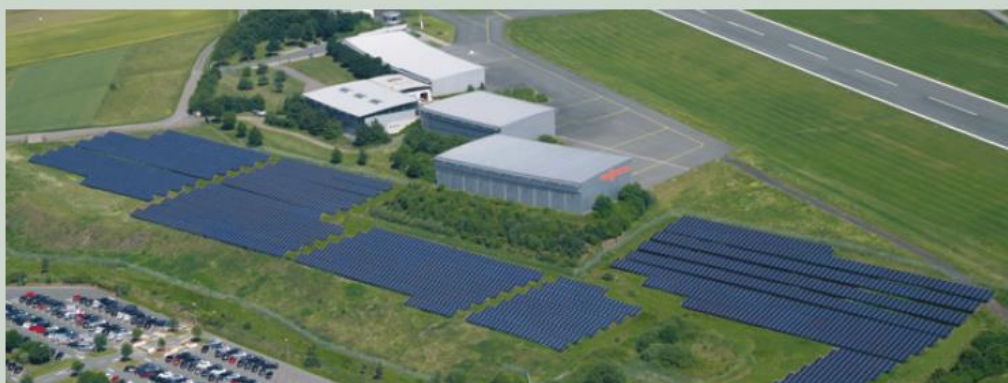
NEI PRESSI DELLO STABILIMENTO DI ALLENDORF È STATO INSTALLATO UN IMPIANTO FOTOVOLTAICO DA 1,8 MWp. COSTITUITO DA OLTRE 7MILA MODULI
